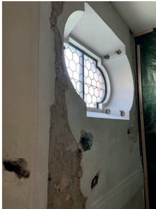
Bild 34 Einbau von V2A- Nadelanker
