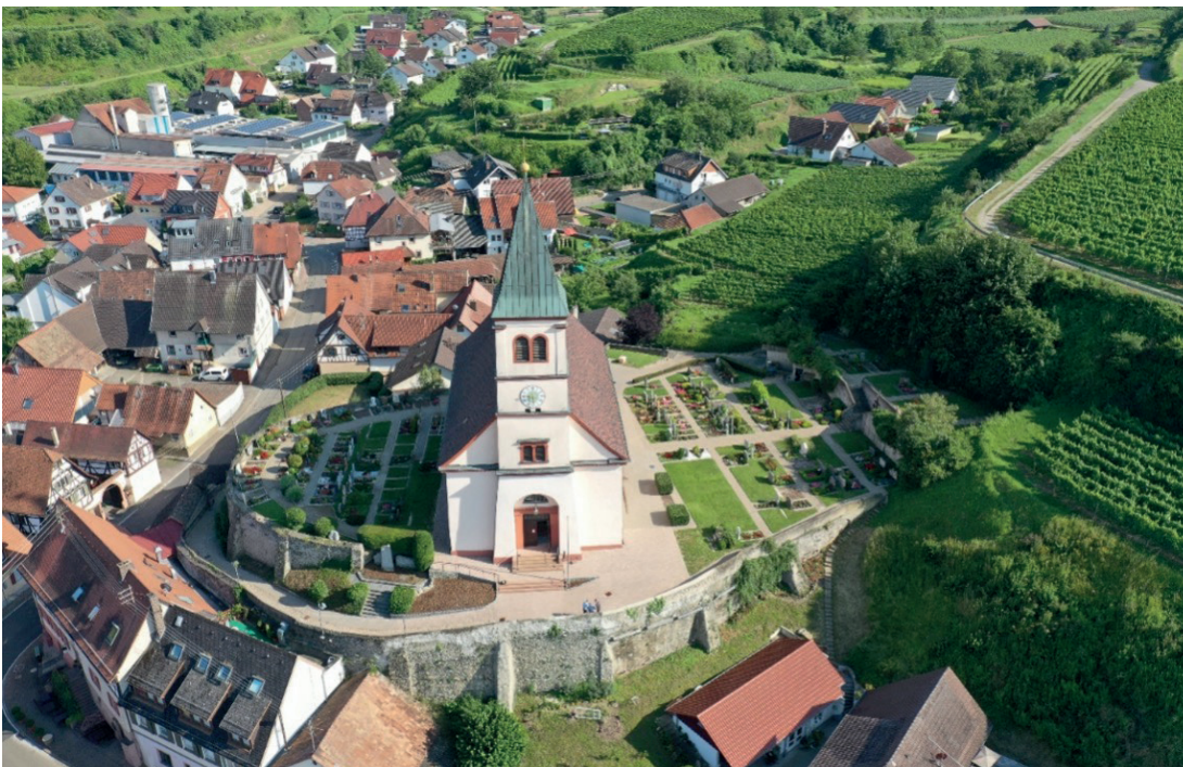
Bild 36 Kirchenansicht Nord nach fertiggestellter Sanierung (20.11.2020)
