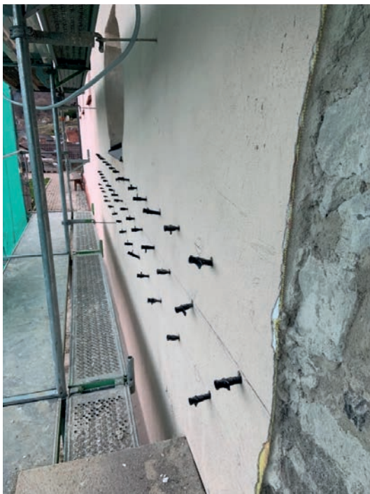
Bild 33 a+b Einbau von Injektionsstutzen
