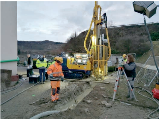
Bild 20 Einbringung der Bohrungen durch Friedhofsmauer zur Bodenvernagelung am 08.11.2018
