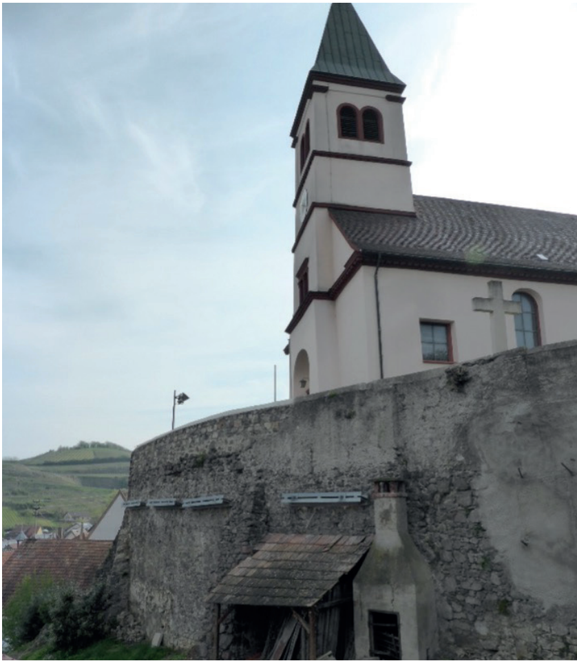
Bild 2 Blick auf Kirchturm und Friedhofsmauer
