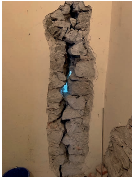
Bild 29 Freigelegte Risse bis 8 cm – nordöstliche Gebäudeecke
