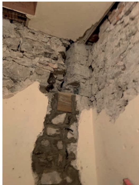
Bild 31 Vernähen der Risse und Einbau von Steinquadern
