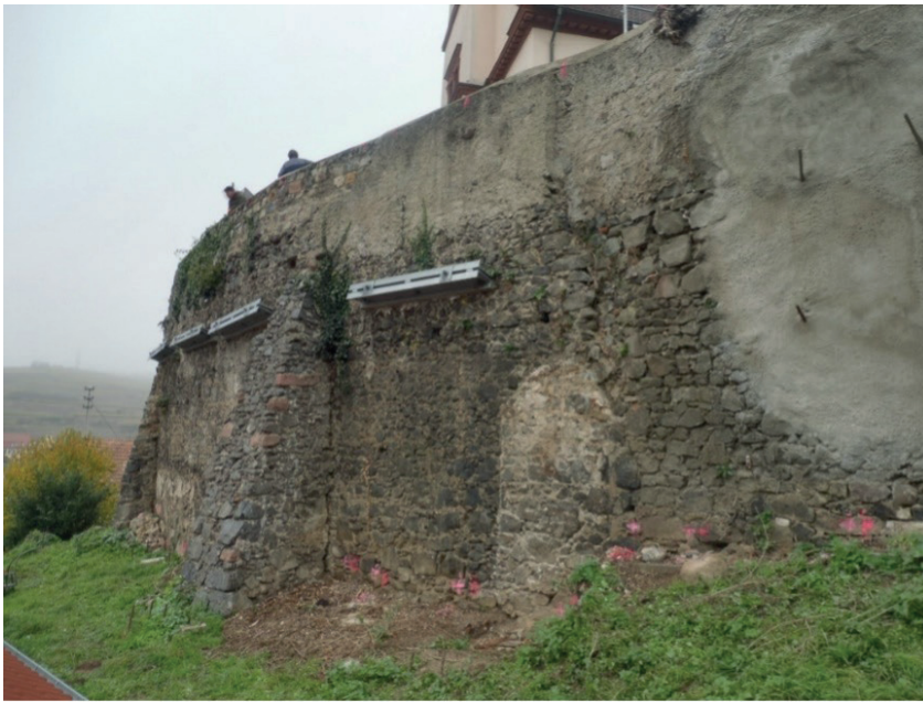
Bild 5 Ansicht Friedhofsmauer mit Notsicherungen (Ischebeck-Mikropfähle und Gurtungen) sowie Spritzbetonausbesserung nach Mauerwerksausbrüchen
