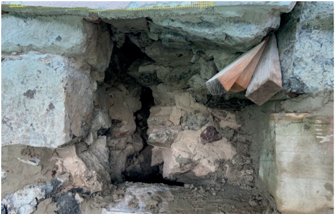
Bild 32 Sicherung lose Steine
