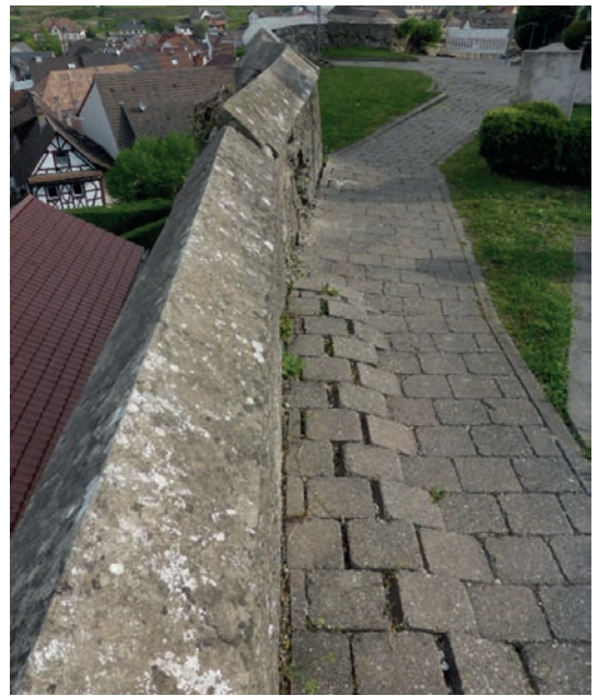
Bild 6 Absenkungen hinter der Friedhofsmauer aufgrund Stützmauerverformungen
